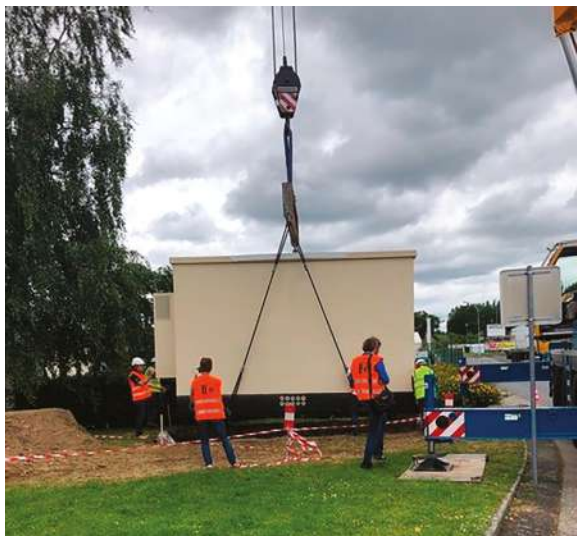
Pose du NRO (Noeud de Raccordement Optique) de Bellac.
