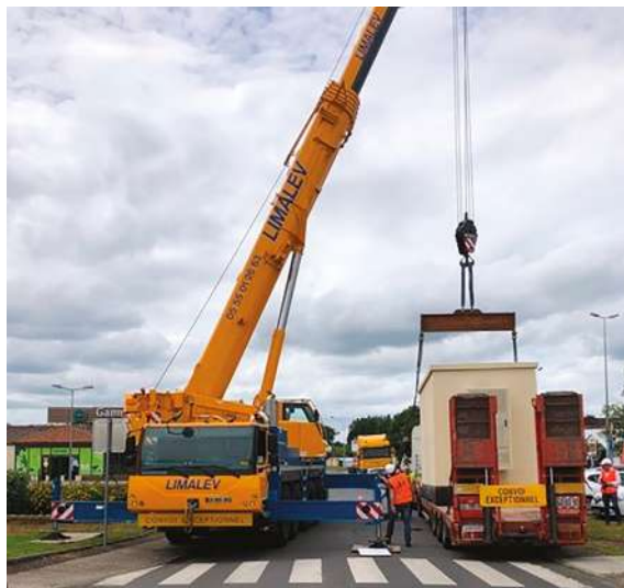
Pose du NRO (Noeud de Raccordement Optique) de Bellac.
