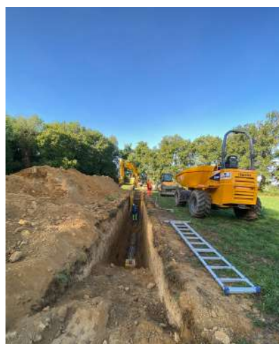
Opération sur les réseaux Arnac-la-Poste
