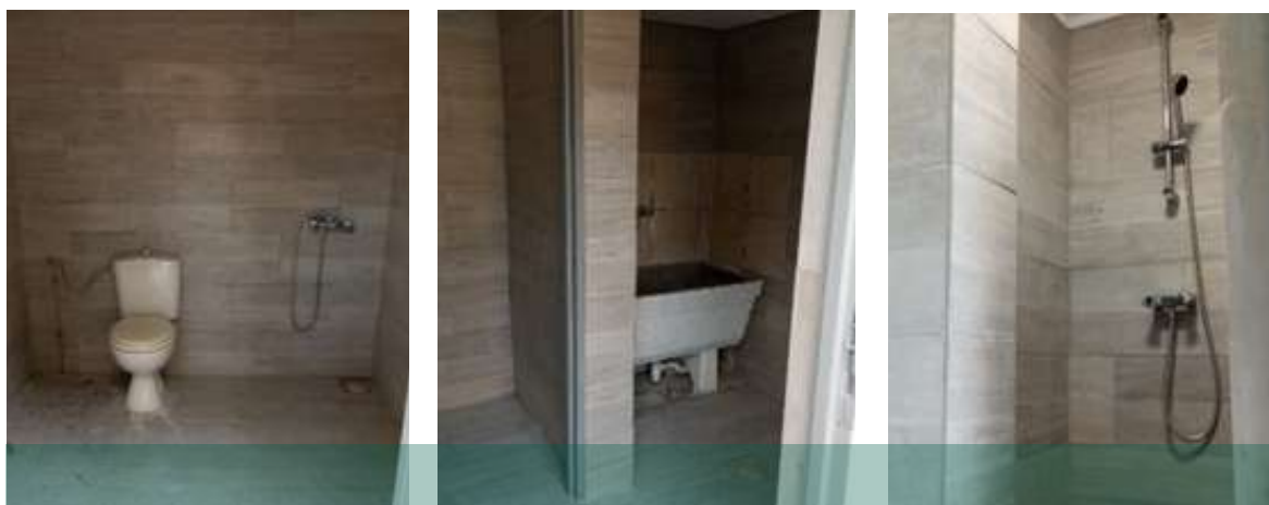
Aire d'accueil : remplacement pendant la fermeture annuelle des revêtements par du carrelage au sol et au mur.
