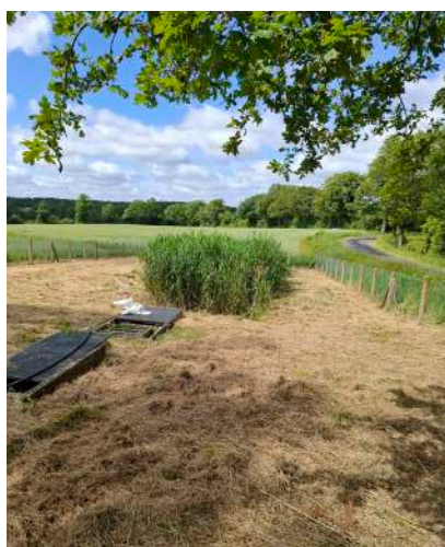
Filtre planté de roseaux à Montrol-Sénard
