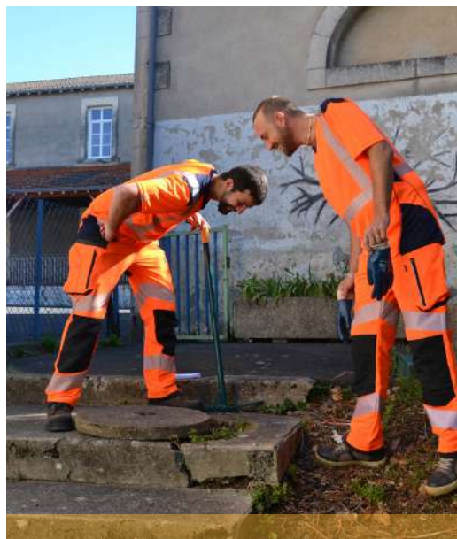
Contrôle du réseau d'assainissement du bâtiment Charles Silvestre à Bellac
