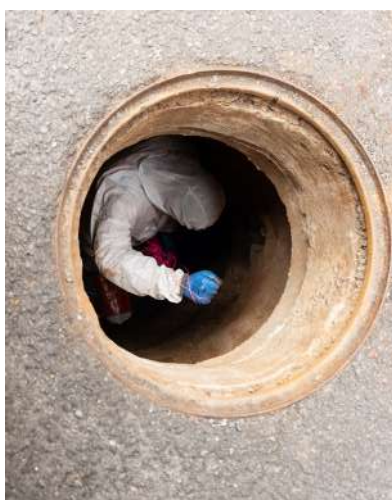
Travaux de chemisage Bellac
