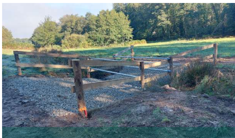
sécurisation d'une traversée pour protéger les berges d'un cours d'eau - Montrol-Sénard
